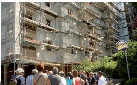
1 - Rénovation énergétique de logements privés
