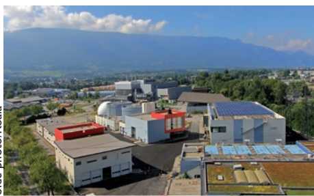
2 - Rénovation de l'usine de dépollution de l'eau
